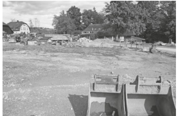
Auf diesem Grundstück zwischen Bauhof und künftigem Feuerwehrhaus soll die neue Rettungswache des Roten Kreuzes entstehen.
