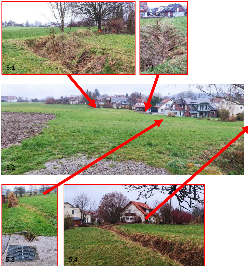
Abbildung 5: (1) Ansicht auf den angelegten Entwässerungsgraben der angrenzenden Grundstücke vor dem Hangwasser. (2) Ansicht von Süden auf das Plangebiet. Die bisherigen Maßnahmen zum Schutz vor dem Hangwasser wurden markiert. (3) Abfluss, der die angrenzende Wohnbebauung vor dem austretenden Hangwasser schützt. (4) Der Ödenbach in seinem weiteren Verlauf durch die Bebauung.
